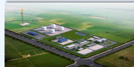
新疆某LNG液厂项目
