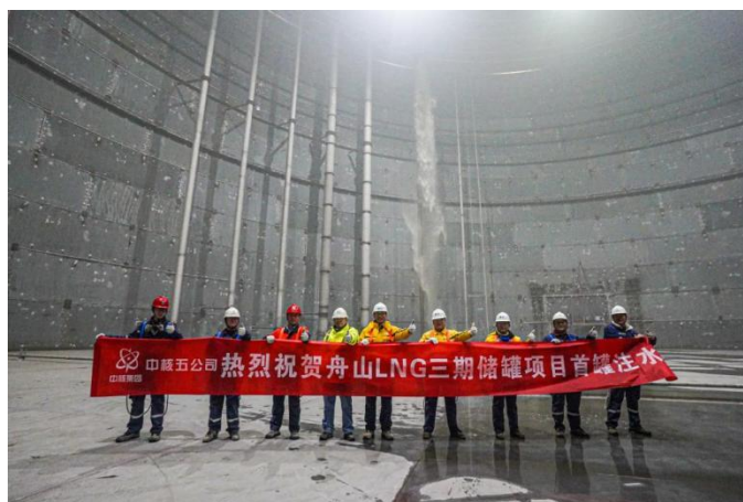
舟山接收站三期项目首罐注水
