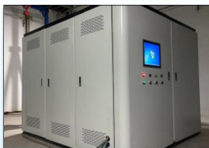
50kW SOFC发电装置
