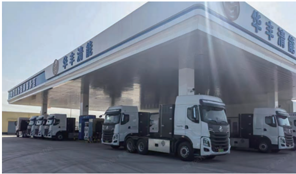
华丰加氢综合能源服务区项目
