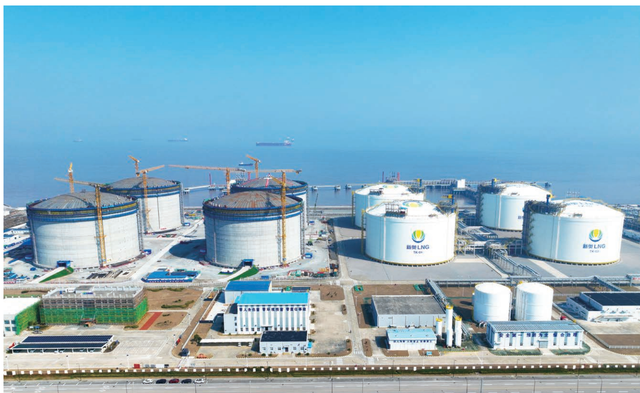
舟山接收站三期四座新增储罐气压升顶成功
