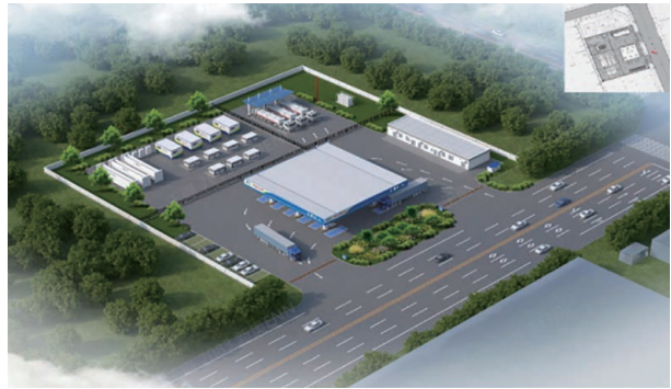
广汇绿电制氢及氢能一体化示范项目
