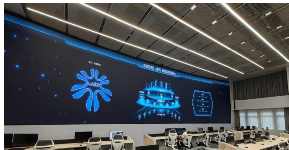
北京大兴临空经济区泛能项目
